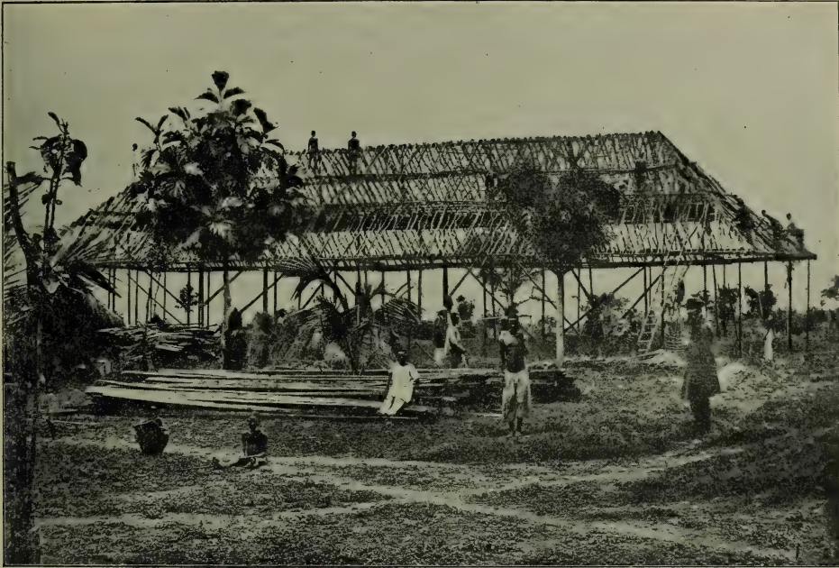
Ein im Bau begriffenes Missionshaus in Ho vor 1870.
